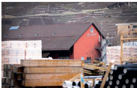
Arrivée du matériel sur le chantier, à proximité du musée actuel.
